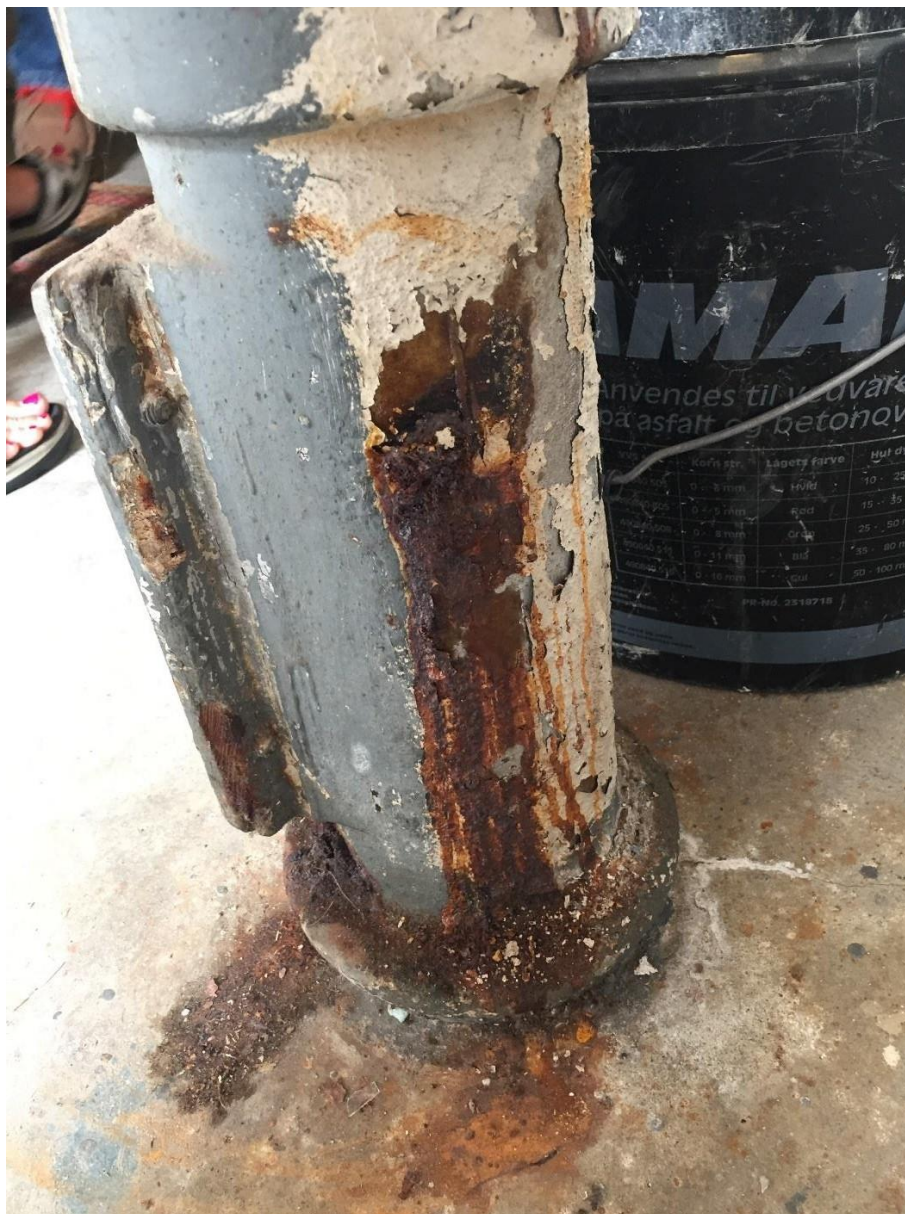
Afløbsrør/faldstamme i kælder
