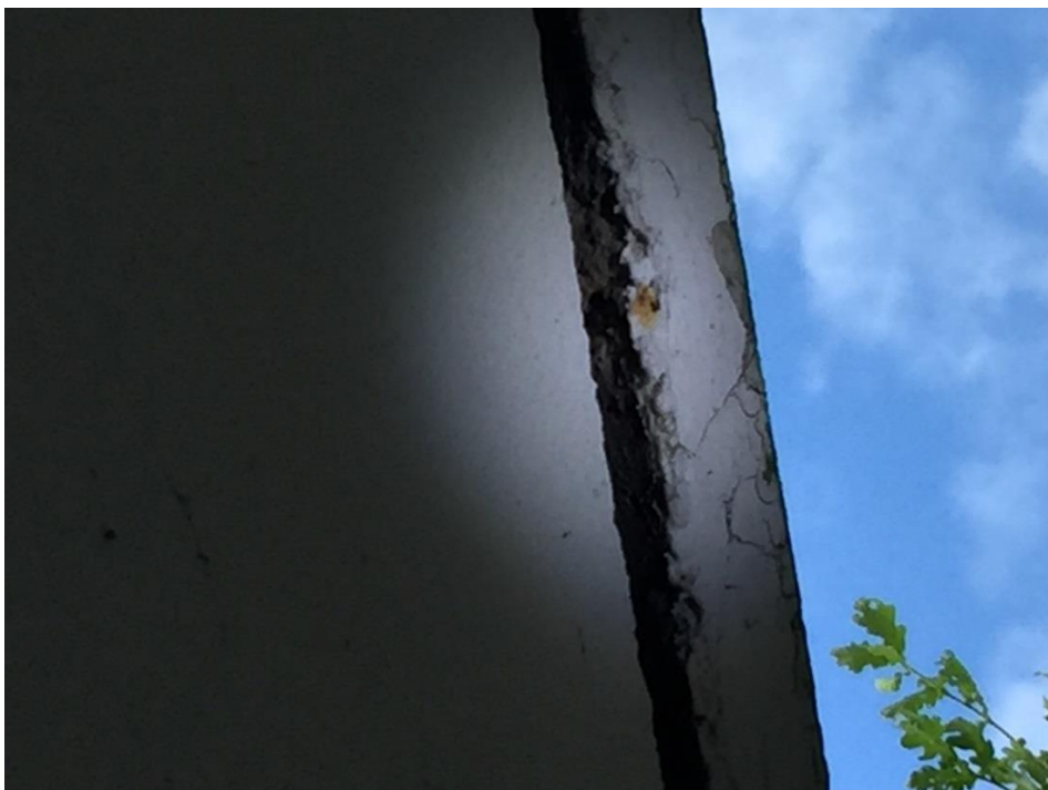
Altan med begyndende tæring af armeringsstålet i elementet
