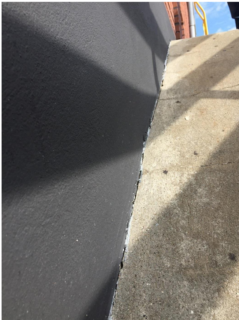
Trappe til kælder, hvor overgangen mellem sokkel og trappe ikke er tæt
