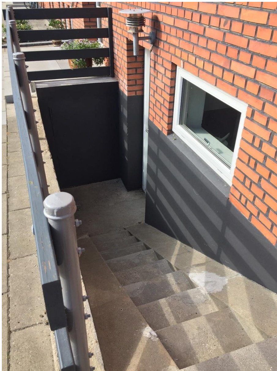
Trappe til kælder med reparationer af beton
