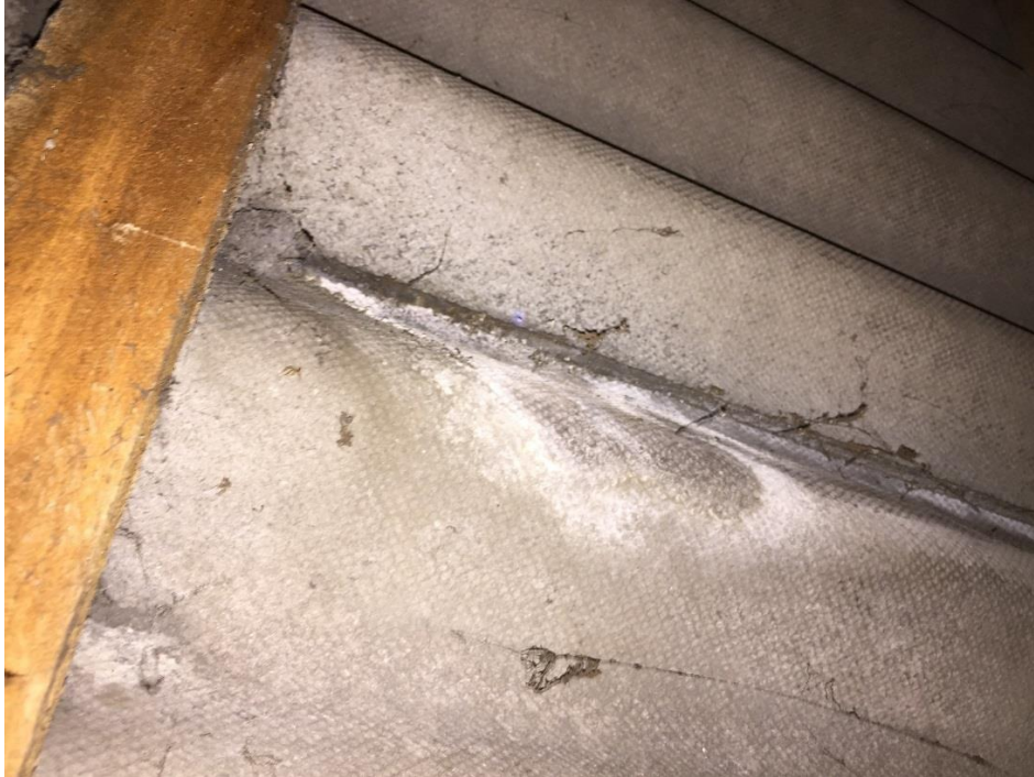
Fugtskjolder ved samlinger i eternitplader
