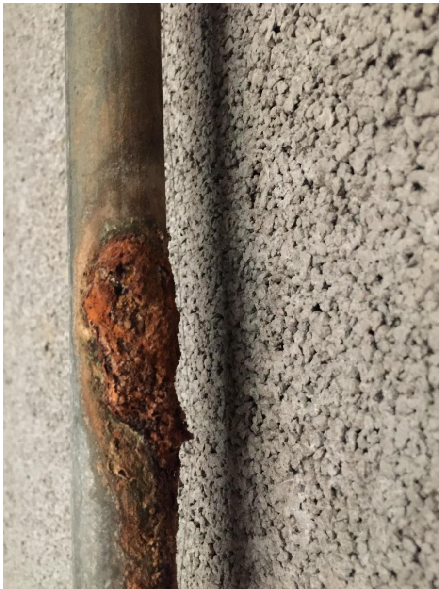
Tæret brugsvandsrør i skakt
