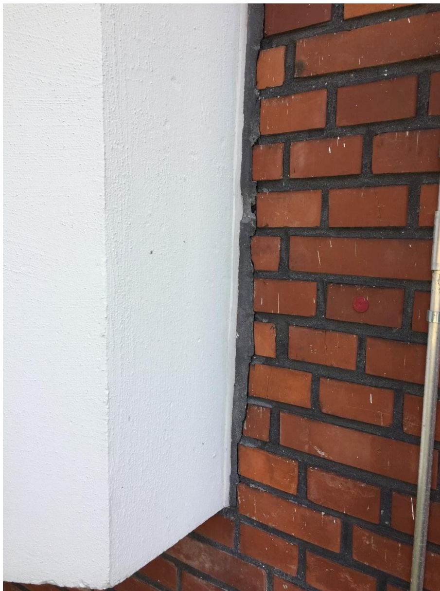
Mørtelfuge ved altan
