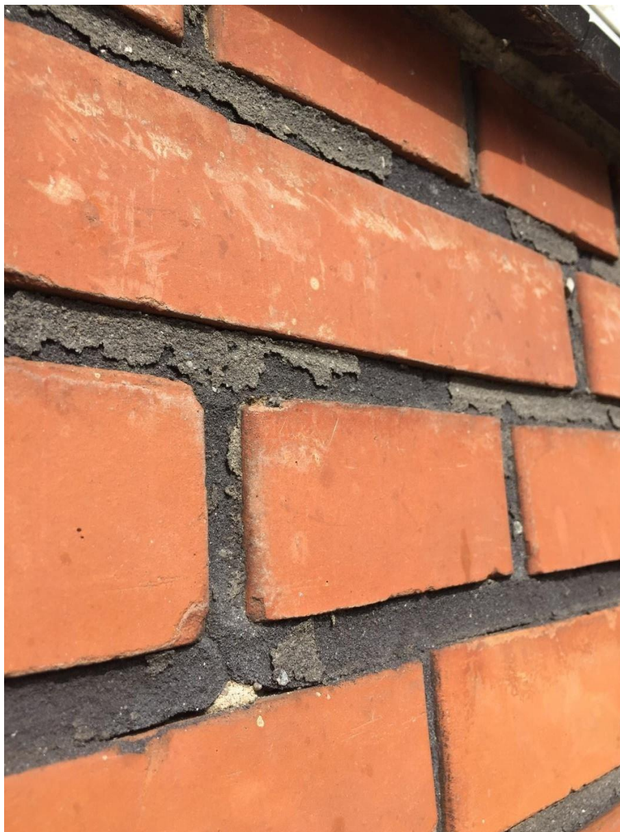
Mørtelfuger i ydervægge
